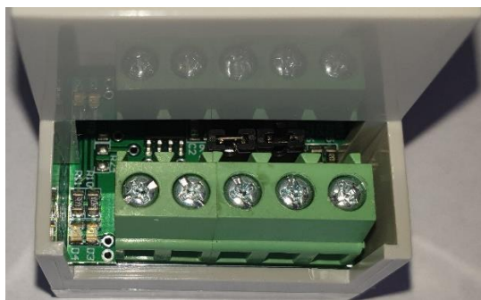
Fot.3.2.1 Widok zamontowanych zwerek terminatora
